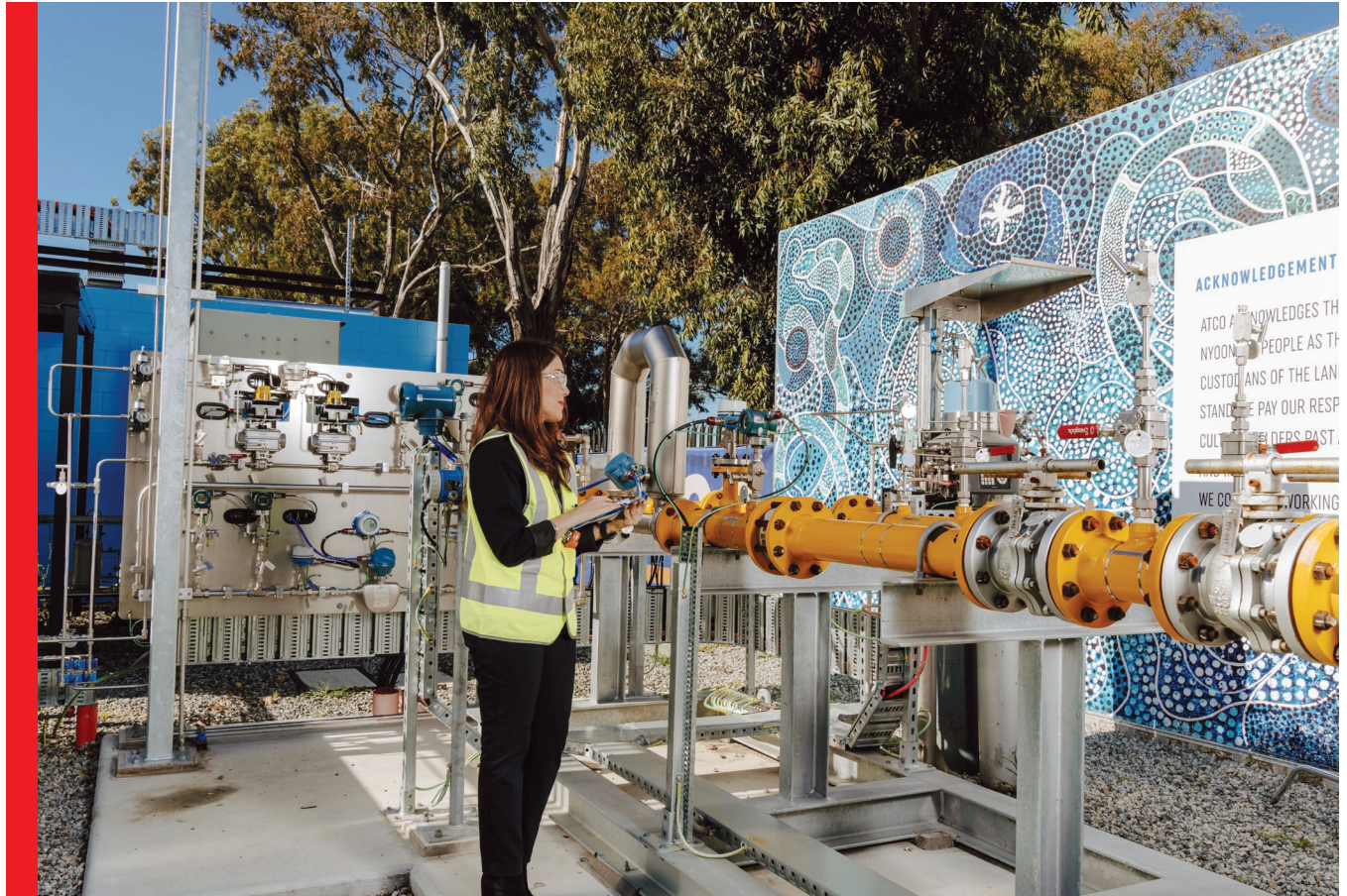
En Australie-Occidentale, ATCO mélange jusqu'à 5 % d'hydrogène renouvelable fabriqué à son centre d'innovation en énergie propre à son gaz naturel afin d'alimenter 2 700 foyers (photo fournie par ATCO)
