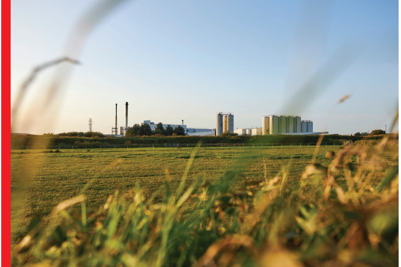
L'usine Saputo de Davidstow, au Royaume-Uni (photo fournie par Saputo)
